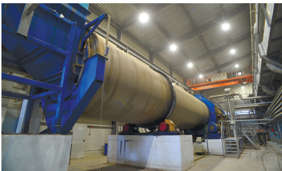
Рис. 1. Гидроразбиватель горизонтального типа
