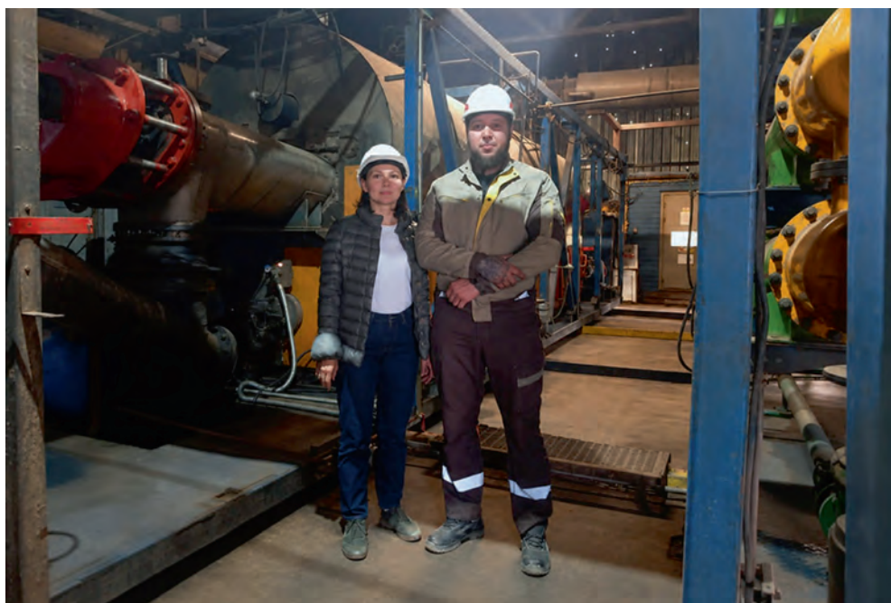
Рис. 1. Рабочий участок установки УТД-2 на объекте «БТ-Промотходы»
